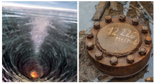
Мал. 81. Верхня частина найглибшої свердловини у світі (максимальна глибина 12262 м, діаметр верхньої частини 92 см, нижньої – 21,5 см). Працювала в 1970–1991 рр. Після кількох аварій у 1994 р. була закрита
